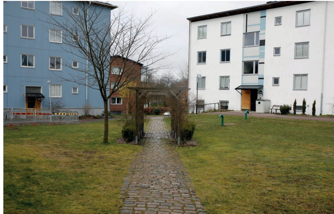
Ett av de avgränsade gårdsrummen i den hästskeformade planstrukturen i södra Biskopsgården. Uppdelningen skapar variation och rum i en mänsklig skala.
