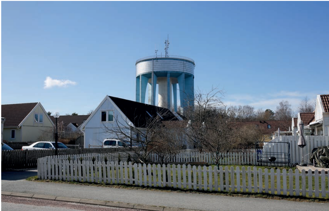
Vy åt väster med Solvädersbyn och vattentornet. Skalan tillåter tornet att vara ett monumentalt landmärke, både inom stadsdelen och från stora delar av övriga Göteborg.
